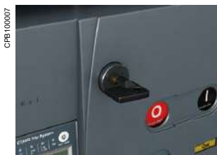
Блокировка врезным замком в положении «отключен»
